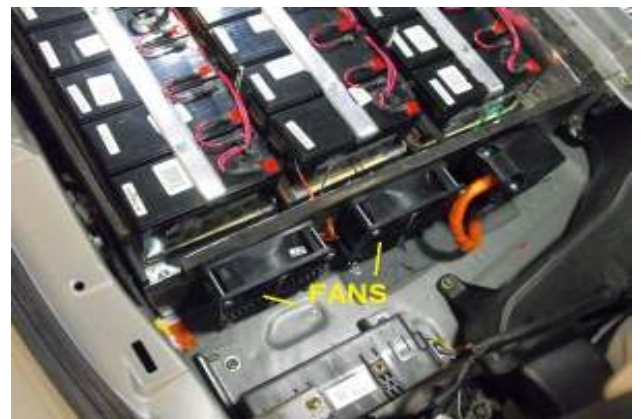
Figura 6: Fans para enfriamiento y ventilación
